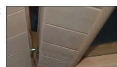
soulever le panneau avec l'encoche mâle puis l'insérer dans l'encoche femelle de l'autre panneau. appuyez vers le bas pour verrouiller.
